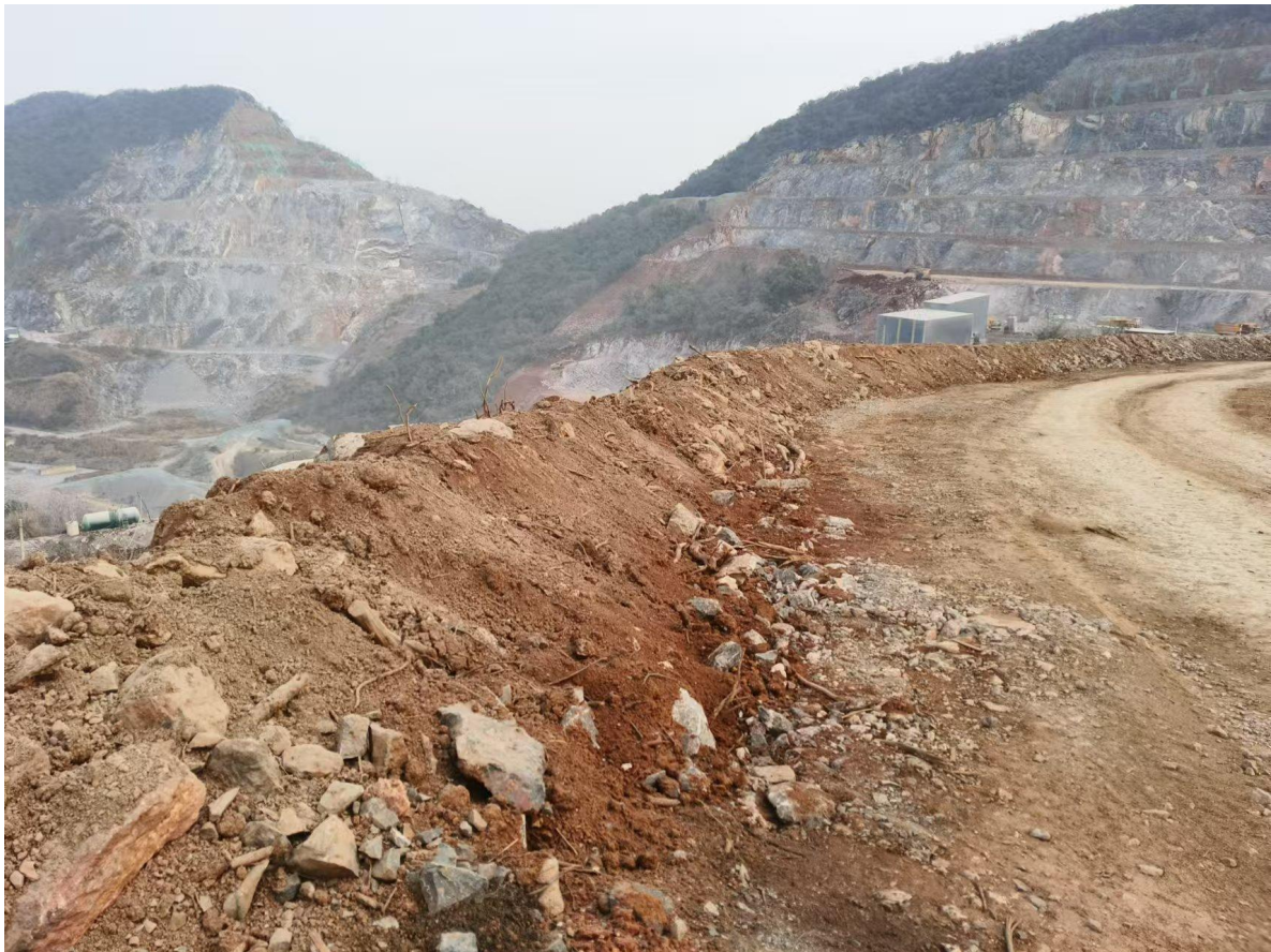
图 2.4-1 运矿道路安全车挡现状图
