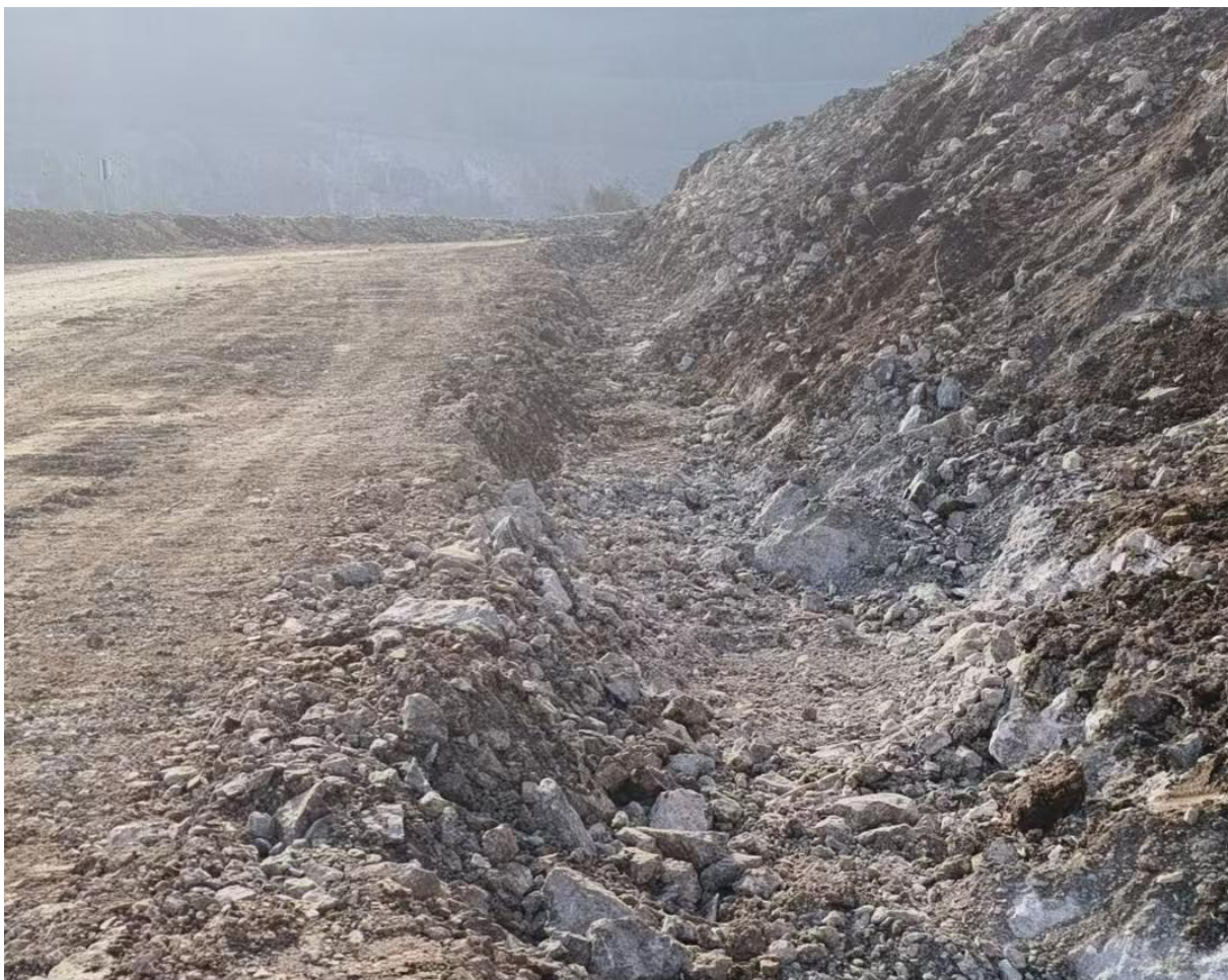
图 2.4-2 道路排水沟现状图
